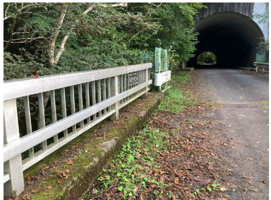
図 4. 生育状況 (3). 橋梁上の路面の端にたまった土の上をはっていた。2021 年 9 月 22 日 相模原市緑区鳥屋. 撮影：大西 亘.
