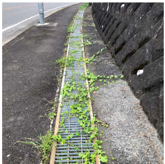
図 5. 生育状況 (4). 歩道の側溝から路面へ伸びてはっていた。2021 年 9 月 22 日 清川村宮ヶ瀬. 撮影：大西 亘.
