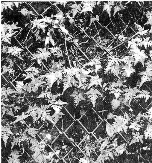
落石防止用の金網から生えるヒメウラジロ（清川村宮が瀬林道 2006 年 12 月 16 日 秋山 守撮影）。
